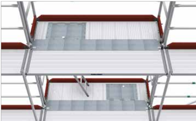
Bild 48: Spaltabdeckung zwischen Aufstiegfeld und Gerüst
