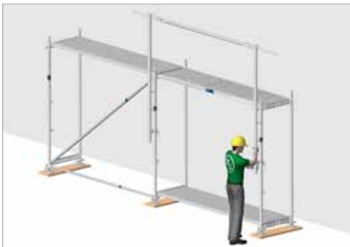
Bild 91: Montage des zweiten MSG-Pfostens
