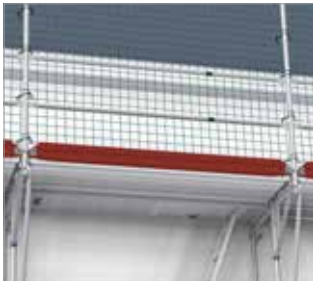
Bild 75: Schutzwand auf zweibohrigen Konsolen
