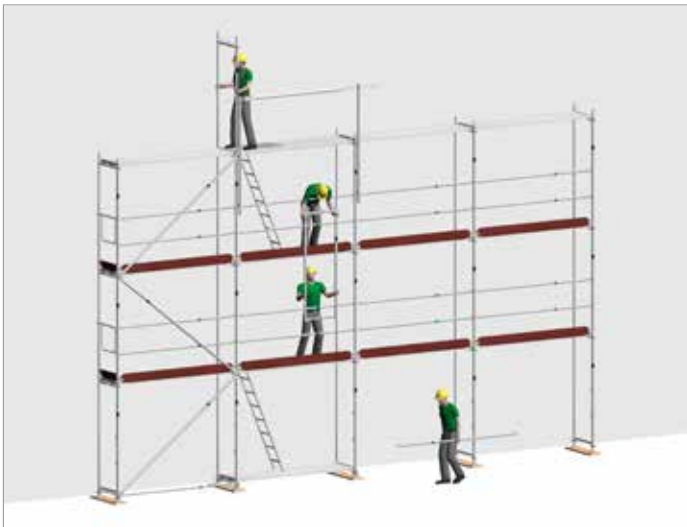
Bild 3: Beispiel für den Vertikaltransport von Gerüstbauteilen von Hand
