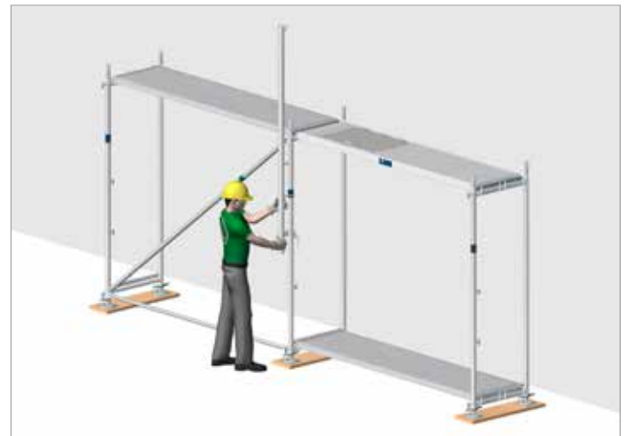
Bild 88: Montage des ersten MSG-Pfostens
