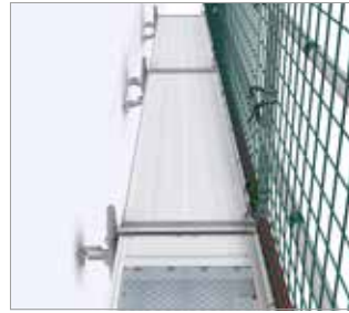
Bild 74: Schutzwand auf Vertikalrahmen (Detail)
