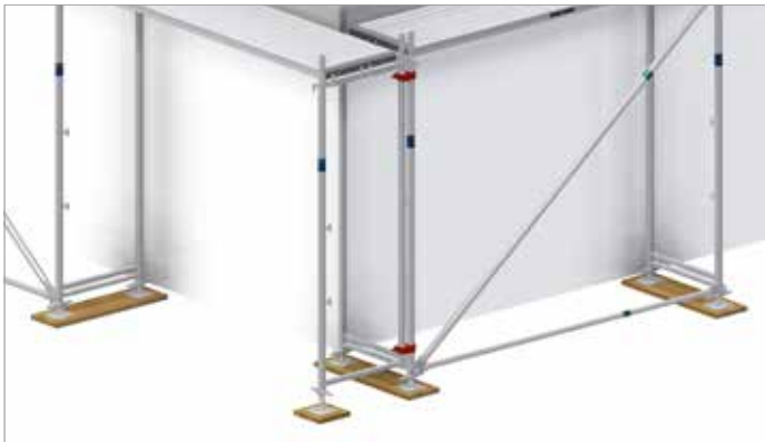
Bild 27: Eckausbildung in der ersten Gerüstlage
