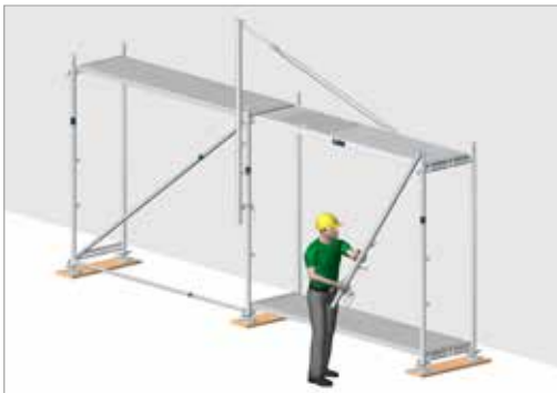
Bild 90: Einhängen des MSG-Geländerholms am zweiten MSG-Pfosten
