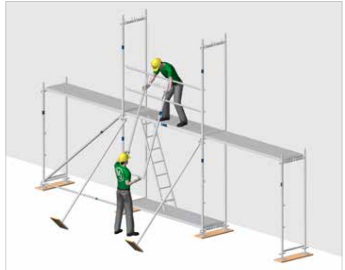
Bild 2: Beispiel für eine vorübergehende Kippsicherung bei Montage der zweiten Gerüstlage
