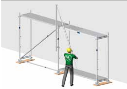
Bild 89: Einhängen des MSG-Geländerholms am ersten MSG-Pfosten
