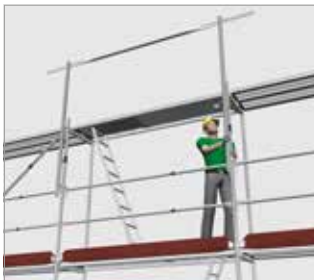
Bild 39: Montage des MSG im Aufstiegsfeld
