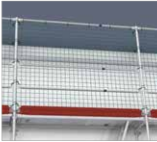
Bild 73: Schutzwand auf Vertikalrahmen
