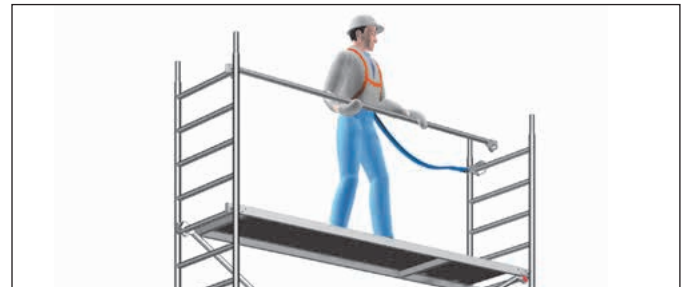
Bild 3: Sichere Montage der Rückenlehnen mit PSA
