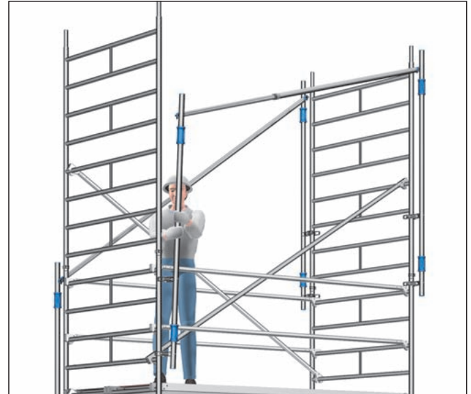
Bild 5: Versetzen des MSG nach oben
