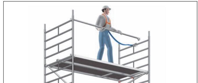
Bild 3: Sichere Montage der Rückenlehnen mit PSA
