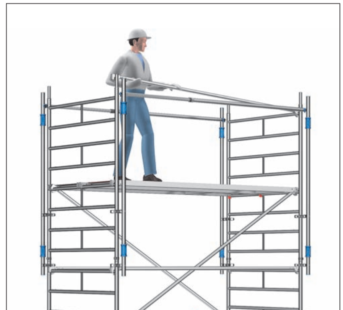
Bild 6: Sichere Montage der Rückenlehnen mit MSG
