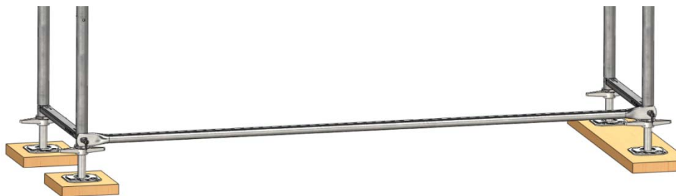
Bild 7: Aufbau des ersten Gerüstfeldes: Längsriegel
